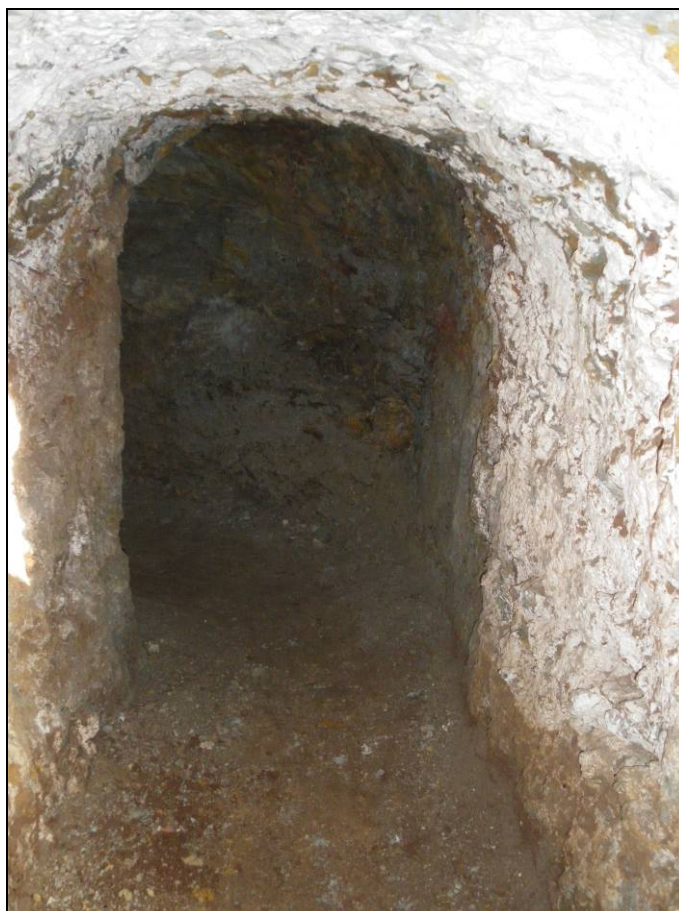
Foto 18: Segon tram de la ziga-zaga un cop buidada la runa.
