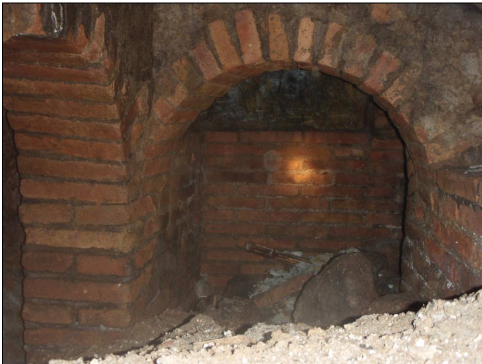
Foto 23: Zona de confluència dels accessos i la galeria (a l'esquerra de la imatge).
