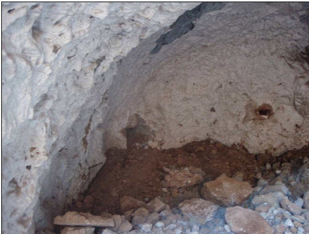
Foto 15: Detall de la zona que quedarà afectada pel rebaix del terreny.
