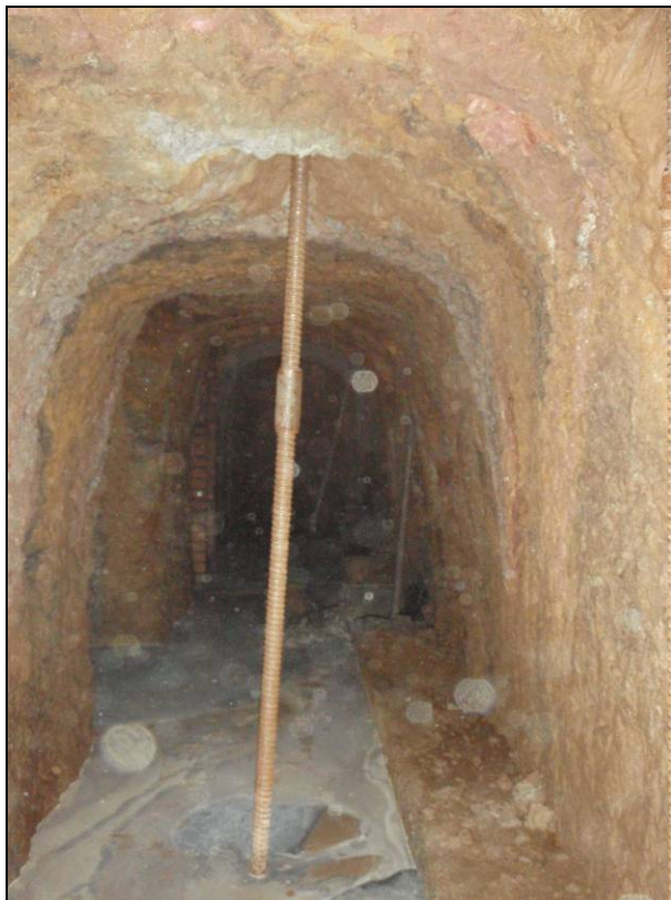
Foto 33: Micropilotatges traspasant la galeria.
