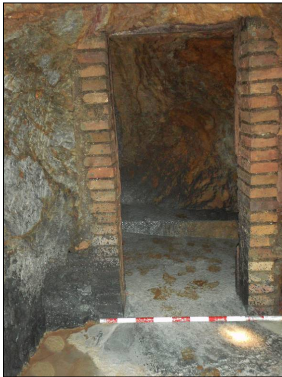
Foto 27: Pilars que flanquegen la porta d'accés a la C1.
