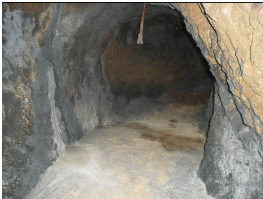
Foto 32: Galeria principal on es veu un dels micropilotatges.
