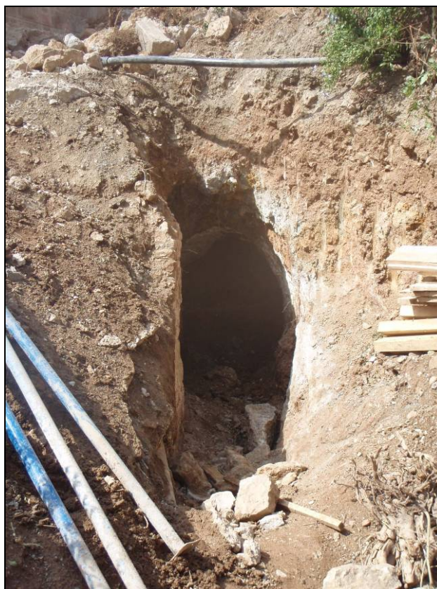
Foto 4: Entrada del refugi descoberta durant les obres.
