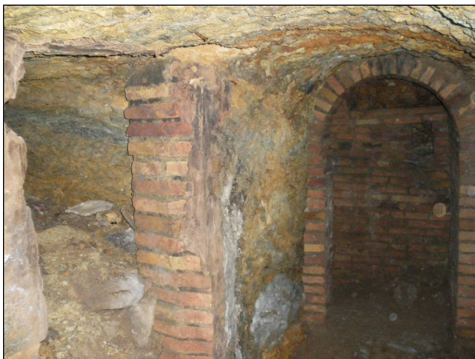
Foto 36: Vista general del passadís nord, a la dreta l'accés des del distribuïdor.
