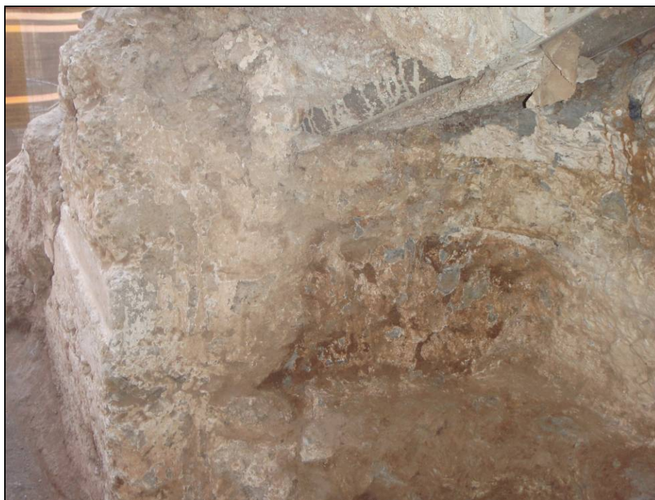
Foto 16: Zona de la volta destruïda en treballs anteriors.
